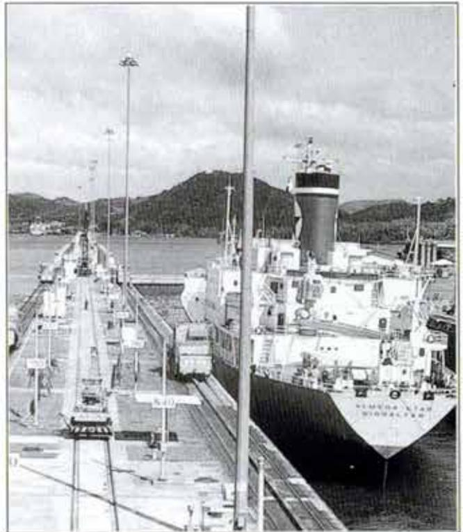
*Las esclusas son gigantescas compuertas capaces de aislar un tramo del canal. Mediante el vertido de agua a ese tramo se consigue elevar los barcos para que puedan navegar a una altura mayor que el nivel del mar, pasando por encima de tierras que de otra forma no permitirían su navegación. Después, para que continúen su travesía por el océano, sólo hace falta retirar el agua que antes se había introducido.*
